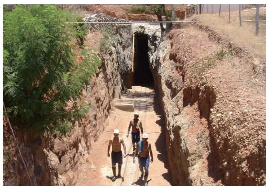
図 15：キントス鉱山坑道入り口
