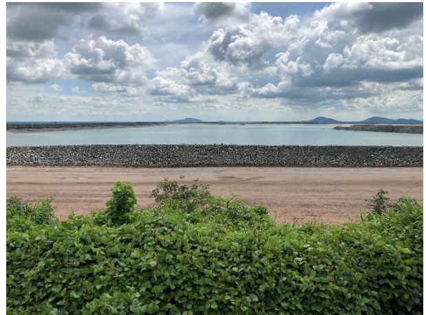
廃液を廃棄するための池
